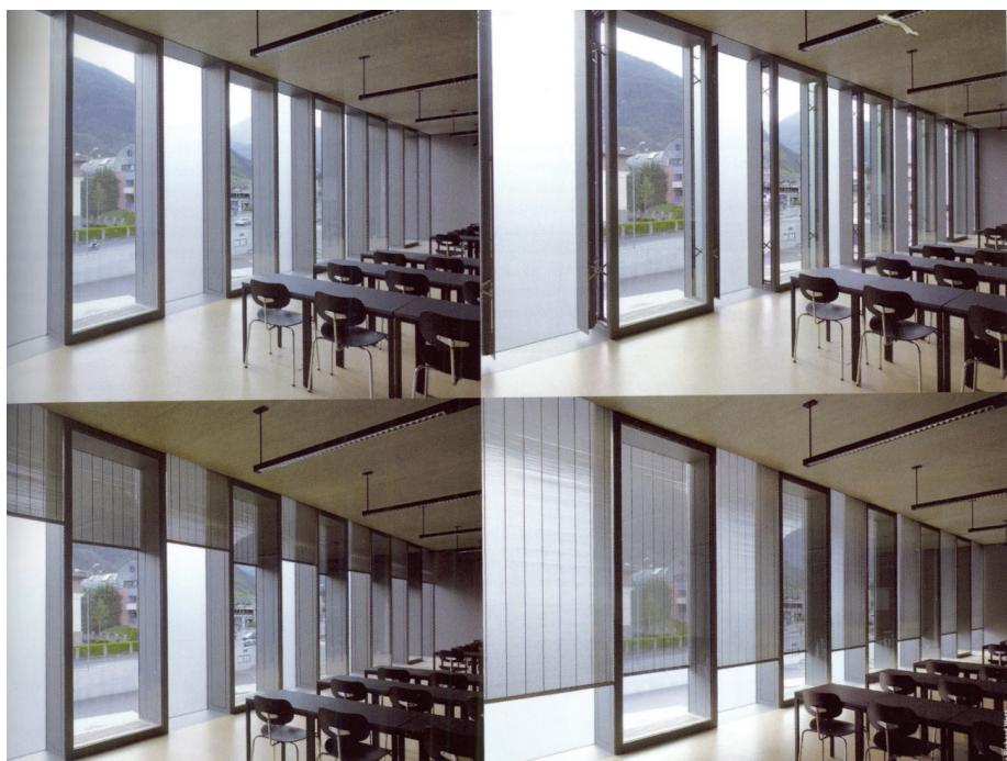
**Figura 17.** Esempio di finestra ad apertura automatizzata per la ventilazione che si ipotizza di utilizzare per la biblioteca (Arketipo 48/10) – *Ejemplo de ventana automatizada para la ventilación que se supone en la biblioteca (Arketipo 48/10).*
