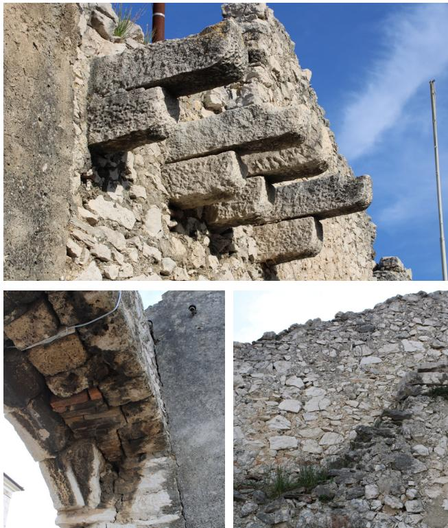
Fig. 5: dettagli tecnologici di quello che resta delle mura.
