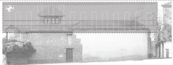
Acquisizione fotogrammetrica UAVs delle coperture dell'edificio non rilevabili con tecnologia laser scanner.
