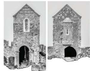
Rilievo fotogrammetrico digitale della chiesa di S. Caterina, eseguito dopo il recente intervento di restauro caratterizzato da un approccio mimetico nella ricostruzione delle parti mancanti del monumento.
