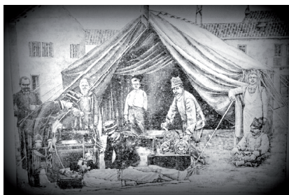
Fig. 10. Stampa fotografica di un ospedale da campo militare italiano, dove si mette in risalto l'uso di una macchina per raggi X utilizzata per una radiografia alla testa di un militare, prima della probabile operazione. Si nota il generatore elettromagnetico (dinamo) azionato a mano da un soldato, che alimenta un grosso rocchetto di Ruhmkorff, la cui tensione del secondario (produttore la scintilla), fornisce l'energia necessaria agli elettrodi del tubo di Roentgen per l'emissione dei raggi X
